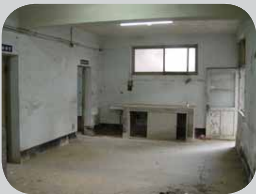
圖7 工坊教學暨金工創作區整修前樣貌
