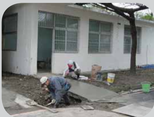
圖9 工人整修工坊入口步道
